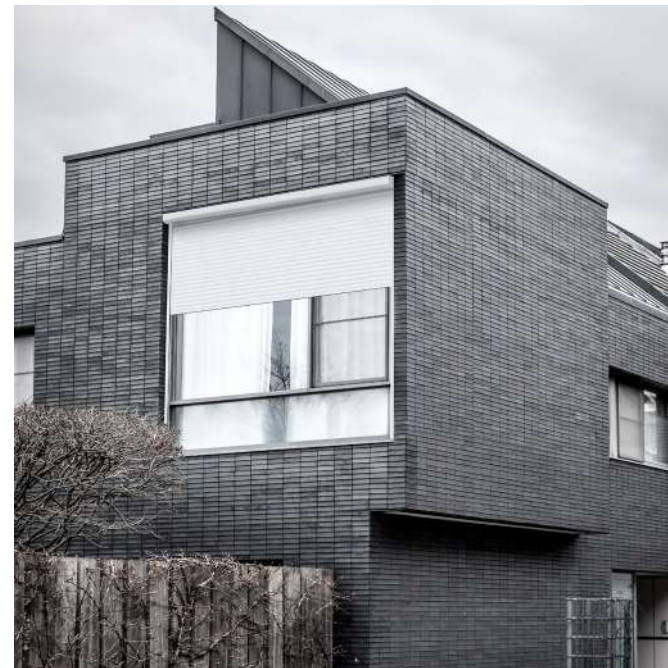
VOILETS ROULANTS RÉNOVATION Page 06
