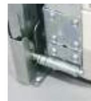
Les points de fixation au sol limitent le déraillement des galets bas en cas de tentatives d'effractions.
