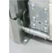
Les points de fixation au sol limitent le déraillement des galets bas en cas de tentatives d'effractions.
